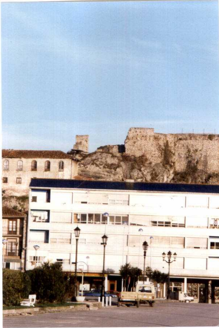
FOTOGRAFIA 1. Vista frontal desde el Paseo de San Vicente, de la roca inestable. Esta queda justo debajo del trcheo de la muralla derribada.
